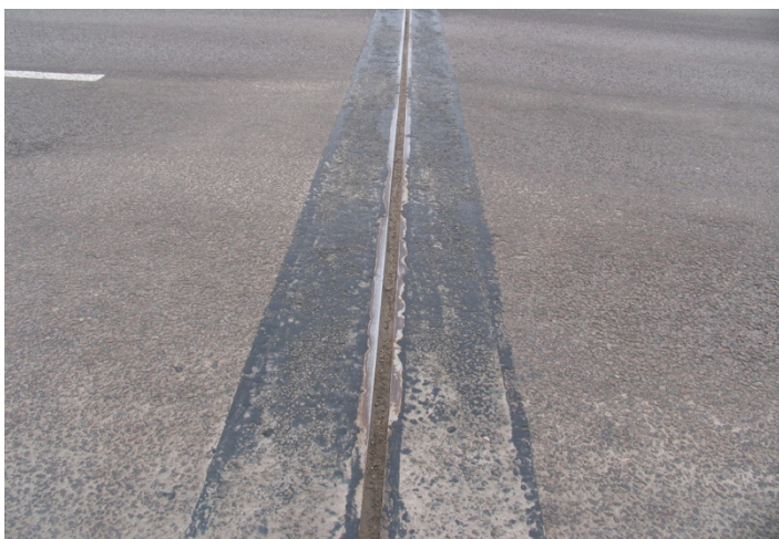
Переходная зона сопряжения асфальтобетонного покрытия с деформационным швом - ПУГМК (ВJ ВАУМ) на путепроводе на пересечении «Малого московского кольца» - км51 М-3 «Украина»
